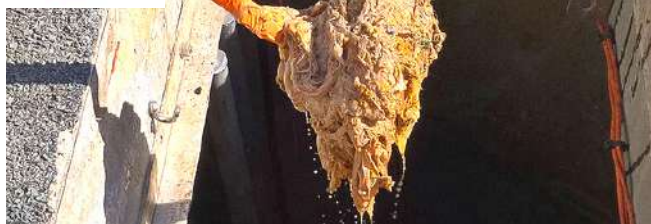
Station d'épuration : Lingettes non dégradées
