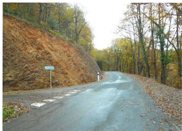
Travaux route de Lagarde viaur
